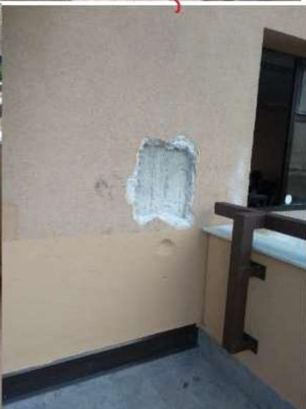
Intervento di disaccoppiamento sismico tra edificio principale e locale palestra con creazione di giunto elastico a filo di parete NORD
